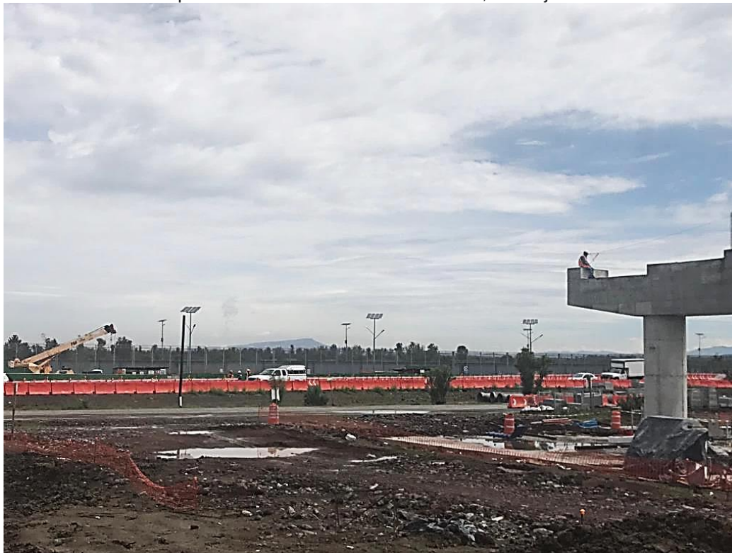
Foto 13. Trabajador sobre el puente que conecta las obras del NAICM con la autopista México-Texcoco. Oscar Ochoa, 24 de junio de 2019
